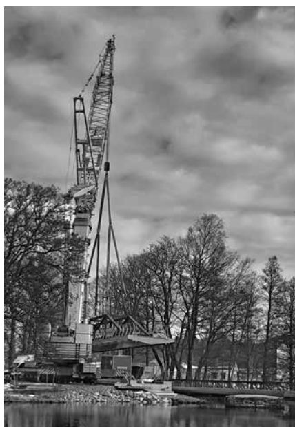
Lyft av själva bron.
